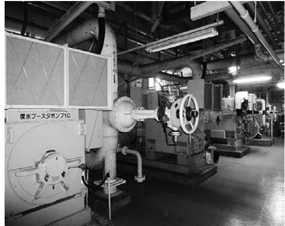
(復水ブースターポンプ撤去前)
