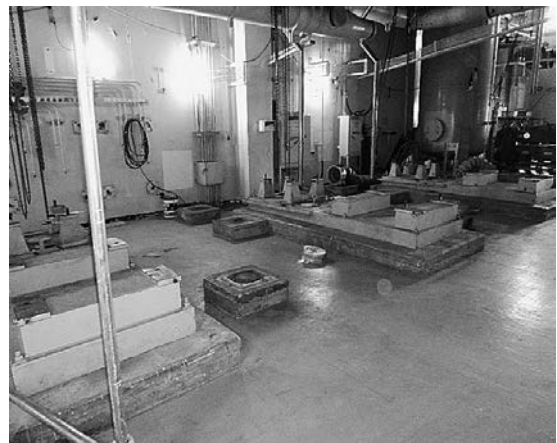
(復水ブースターポンプ撤去後)
